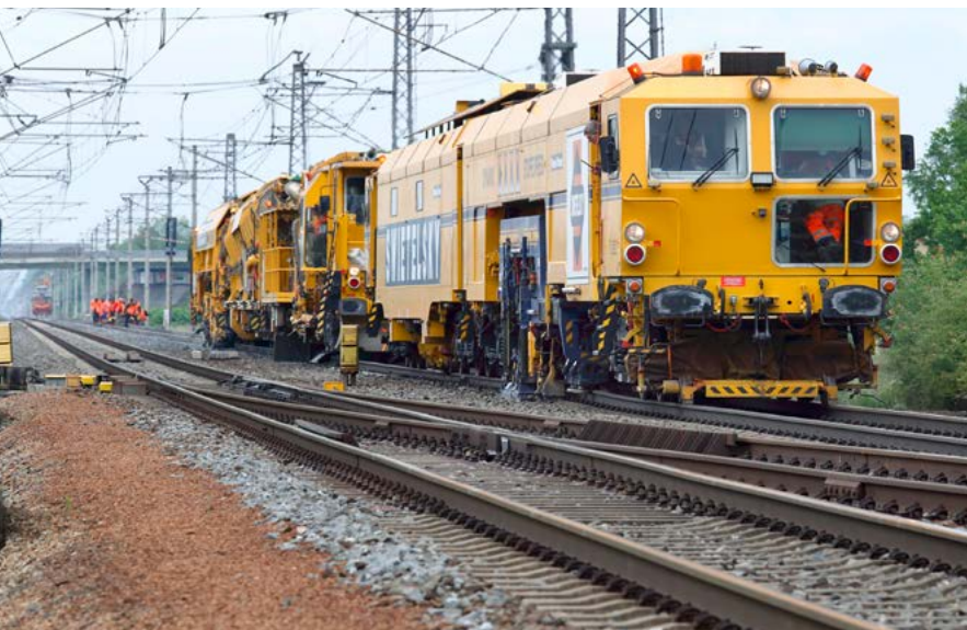
Tamping operations, Zábřeh na Moravě, Tschechien
